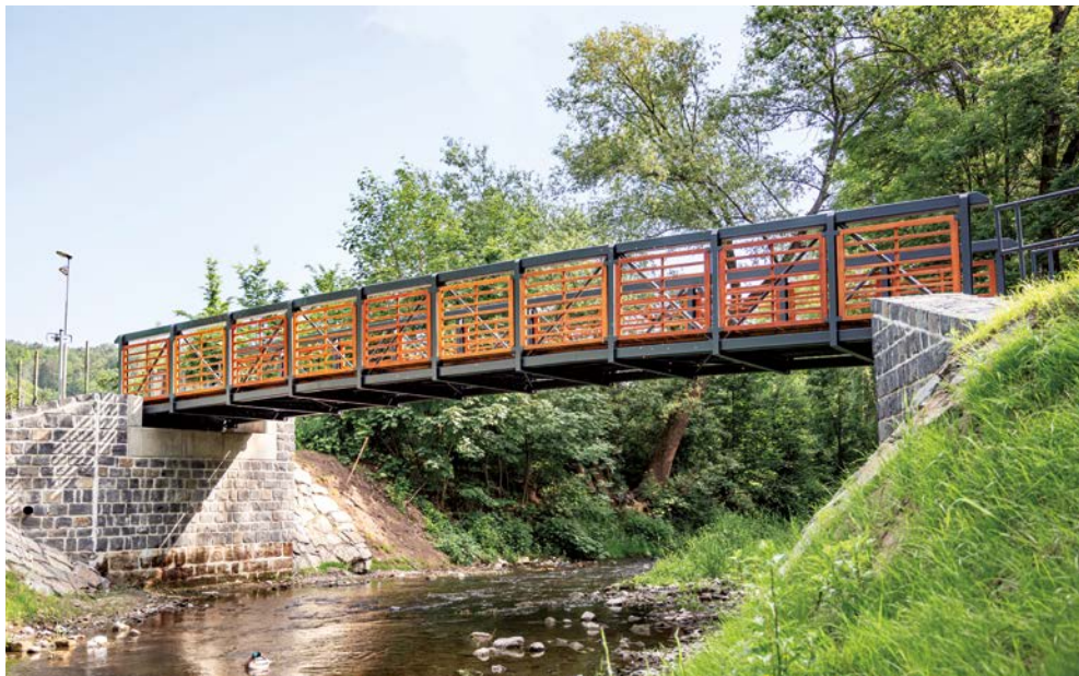
Lávka přes Jílovský potok v Děčíně
